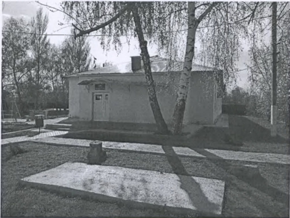
2. Территория, прилегающая к зданию.
