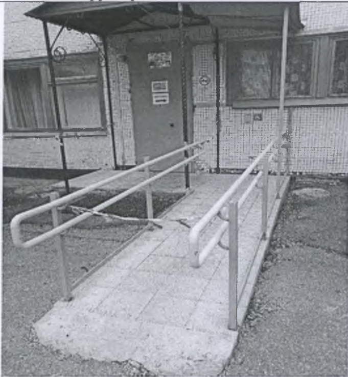
3 Пандус (центральный вход)
